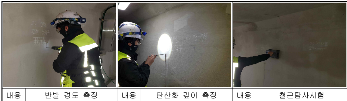
【사진 2.5】 포천인출 전력구 재료시험 전경
